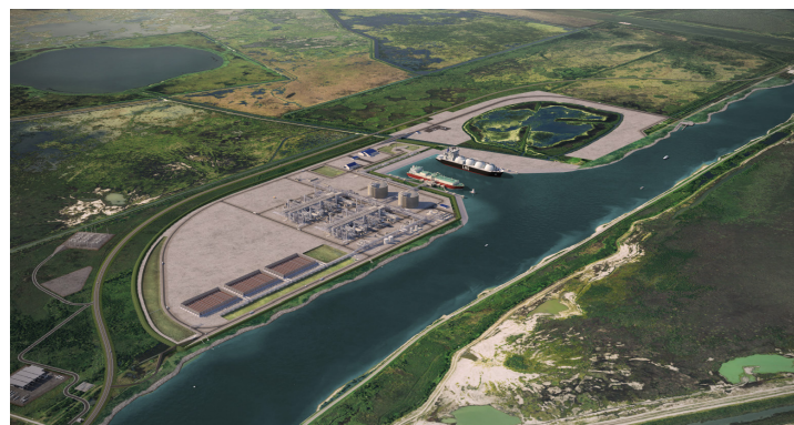
Port Arthur LNG
